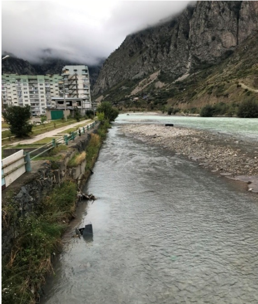
Рисунок 3 – Образование новых накоплений речных наносов в русле реки, меняющих направление водного потока к левому берегу – в направлении дамбы хвостохранилища №1. Проблемы: угрозы дальнейшего ускоренного подмыва (разрушения) откоса дамбы хвостохранилища и попадания экологически вредных отходов ТВМК в реку Баксан, разрушения вантового перехода с инженерными сетями и вантового пешеходного моста через реку Баксан
